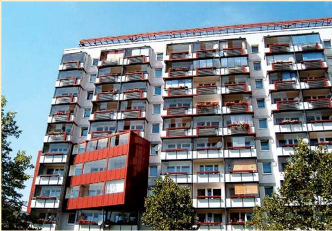
Bild 7: in die Fassade integrierte Balkonbrüstung des Gebäudes Juri-Gagarin-Ring 128-130
